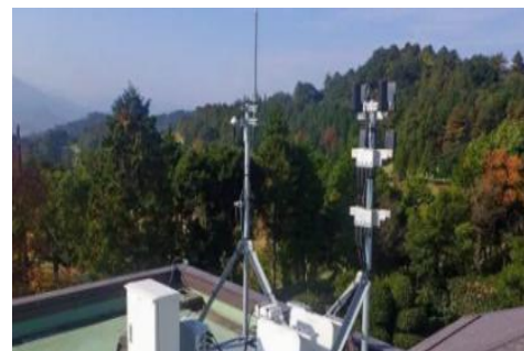
LPWA基地局構築
