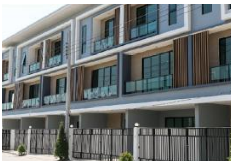
一括型マンション ISP導入工事
