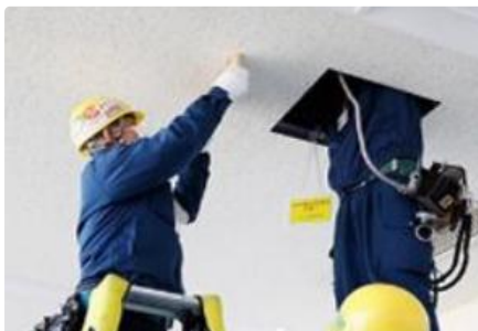
屋内電波対策工事 (5G/4G,LET/3G撤去)
